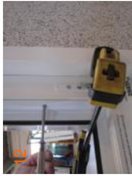
Kontroller hjørerne på alu-tilsætningen er plane.
