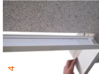
Placer alu-tilsætningen i hullet.
