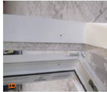
Indsæt karmen i vindueshullet. Husk fugemasse på bagside af overfals
