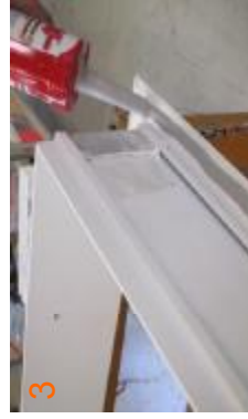
Påfør fugemasse på bagsiden af alu-tilsætningen og karmoverfalsen (se bagside)
