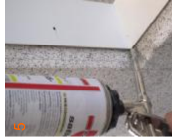
Opklods alu-tilsætningen i hullet. Bagstopning udføres (skum ell. lign.
