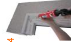
Afslut med hvid fuge mellem karm og alu-tilsætning.
