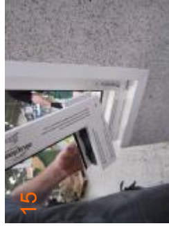
* Påmonter evt. gænde rammer.
